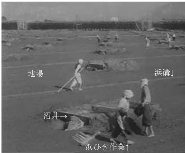
図7 入浜式塩田における作業の様子と構造物
